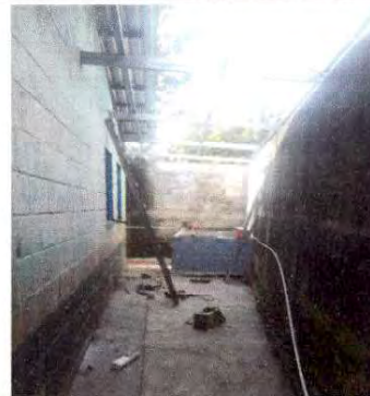
Foto 8: Sustitución de lamina por lamina troquelada aluzinc calibre 26 y Sustitución de estructura de soporte de madera por metal
