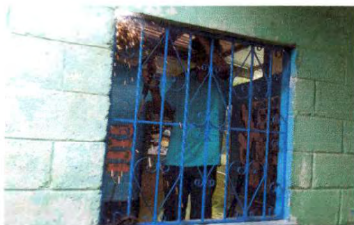
Foto 11: Fabricación e instalación de balcones de Hierro en ventanas
