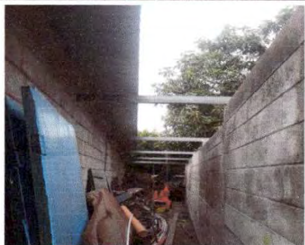
Foto 9: Sustitución de lamina por lamina troquelada aluzinc calibre 26 y Sustitución de estructura de soporte de madera por metal
