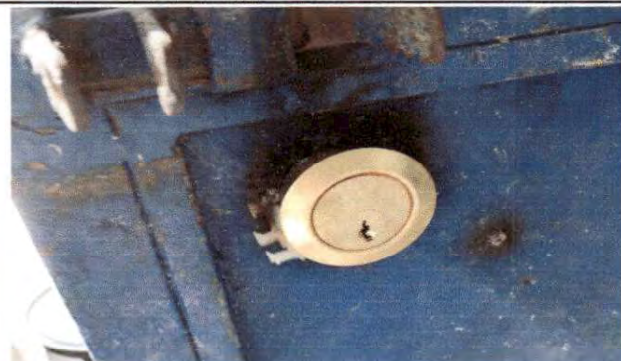
Foto 2: Sustitución de chapa
