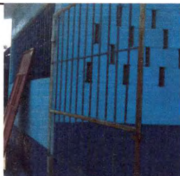
Foto 10: Fabricación e instalación de porton de metal de ingreso.
