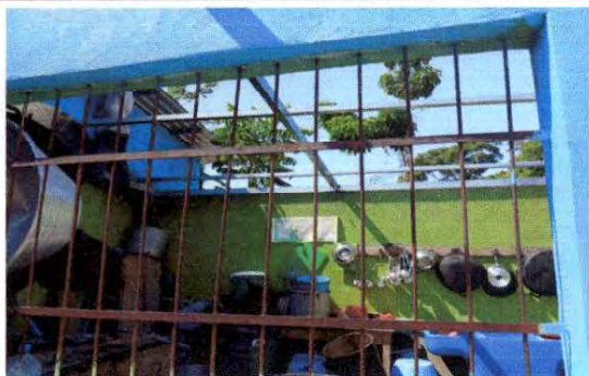
Foto 7: Sustitución de estructura de soporte de madera por metal
