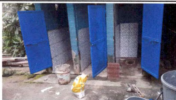
Foto 6: Sustitución de Inodoro y Sustitución de azulejo
