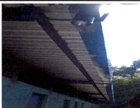
Foto 5: Sustitución de canal de metal
